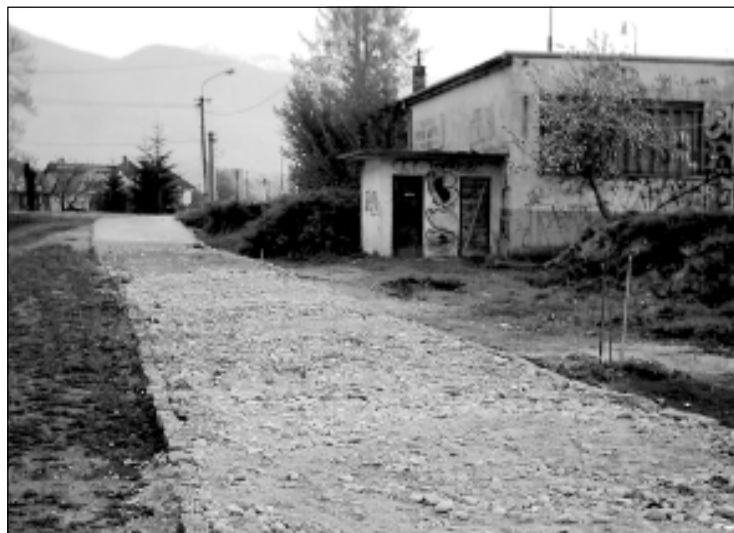
... budujeme prístupovú cestu.
